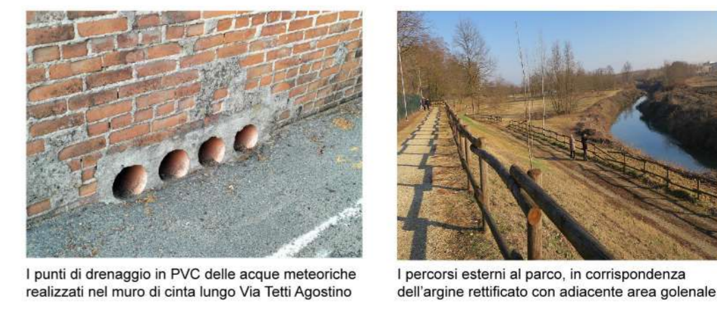
I punti di drenaggio in PVC delle acque meteoriche realizzati nel muro di cinta lungo Via Tetti Agostino I percorsi esterni al parco, in corrispondenza dell'argine rettificato con adiacente area golenale
