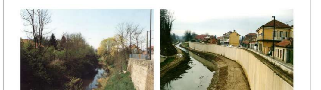
Rinforzi della sponda destra: prima dell'evento alluvionale e successivo rifacimento
