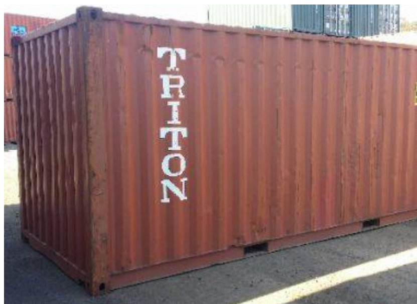
Illustrazione 3.8 – Condizioni estetiche esterne di un container di grado B
