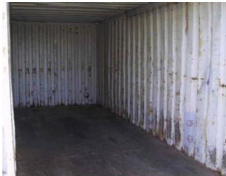
Illustrazione 3.11 – Condizioni estetiche interne di un container di grado C
