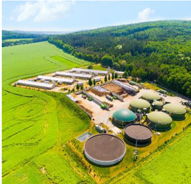
Fig. 2.5 Impianto di produzione di biometano in Francia
