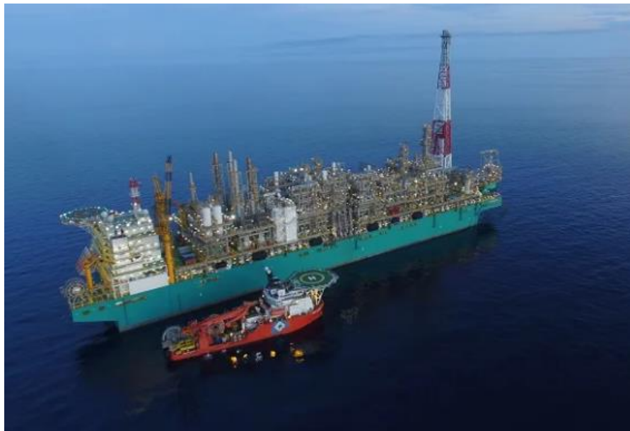
Fig. 2.1 Impianto offshore galleggiante di liquefazione e stoccaggio PFLNG SATU
