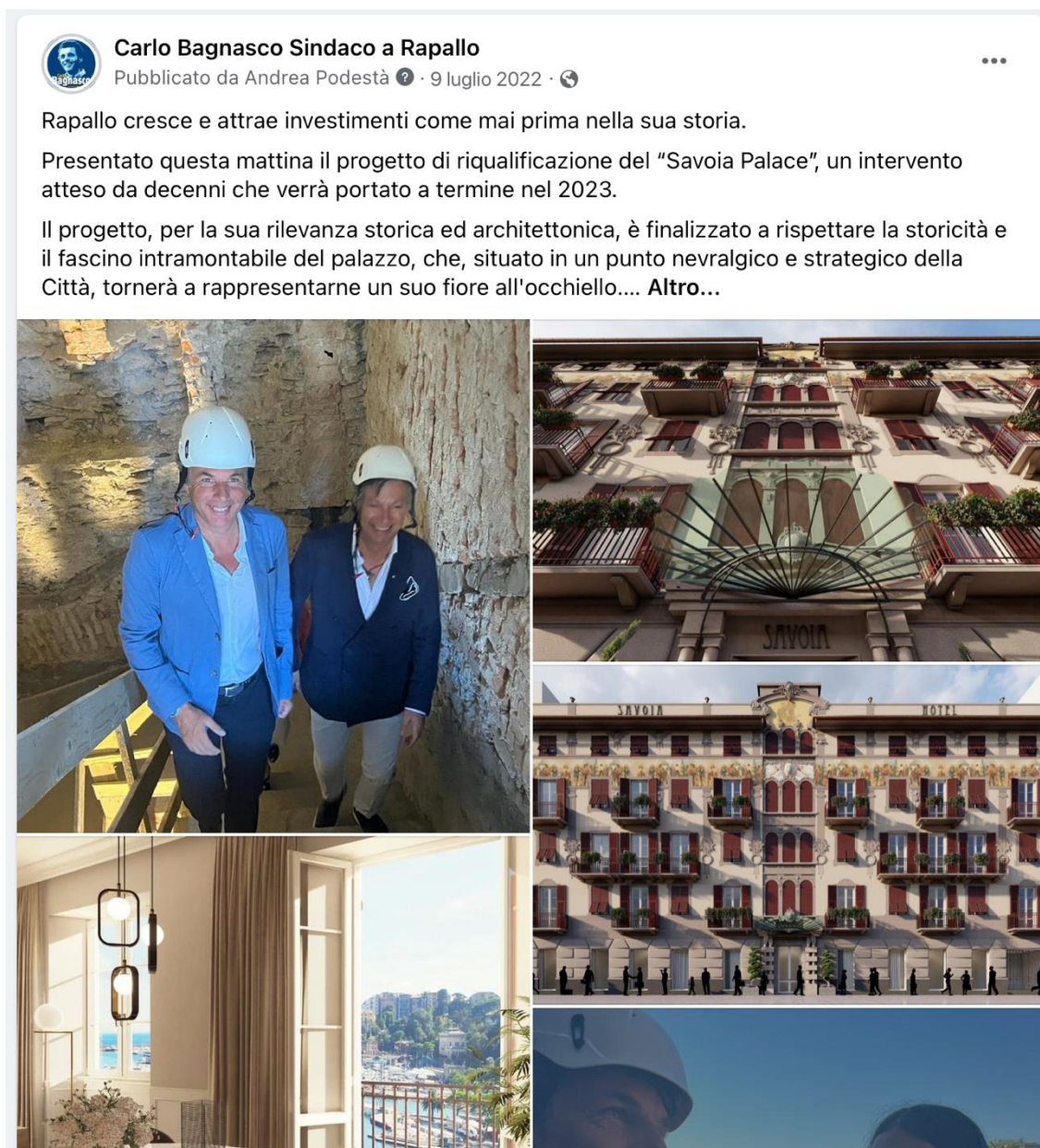
Figura 15.4 Visita al cantiere di riqualificazione dell'ex "Hotel Savoia"
