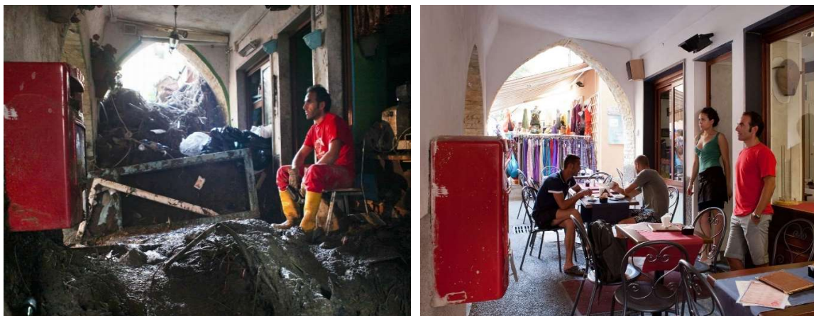
Fig. 7: Foto ritraenti il bar Davi in via Roma nel paese di Monterosso. A destra uno scatto che mostra la devastazione causata dall'alluvione, a sinistra il nuovo volto del bar. Fonte: https://www.focus.it/ambiente/natura/prima-e-dopo-le-cinque-terre-ricostruite-e-ripulite-dopo-l-alluvione
