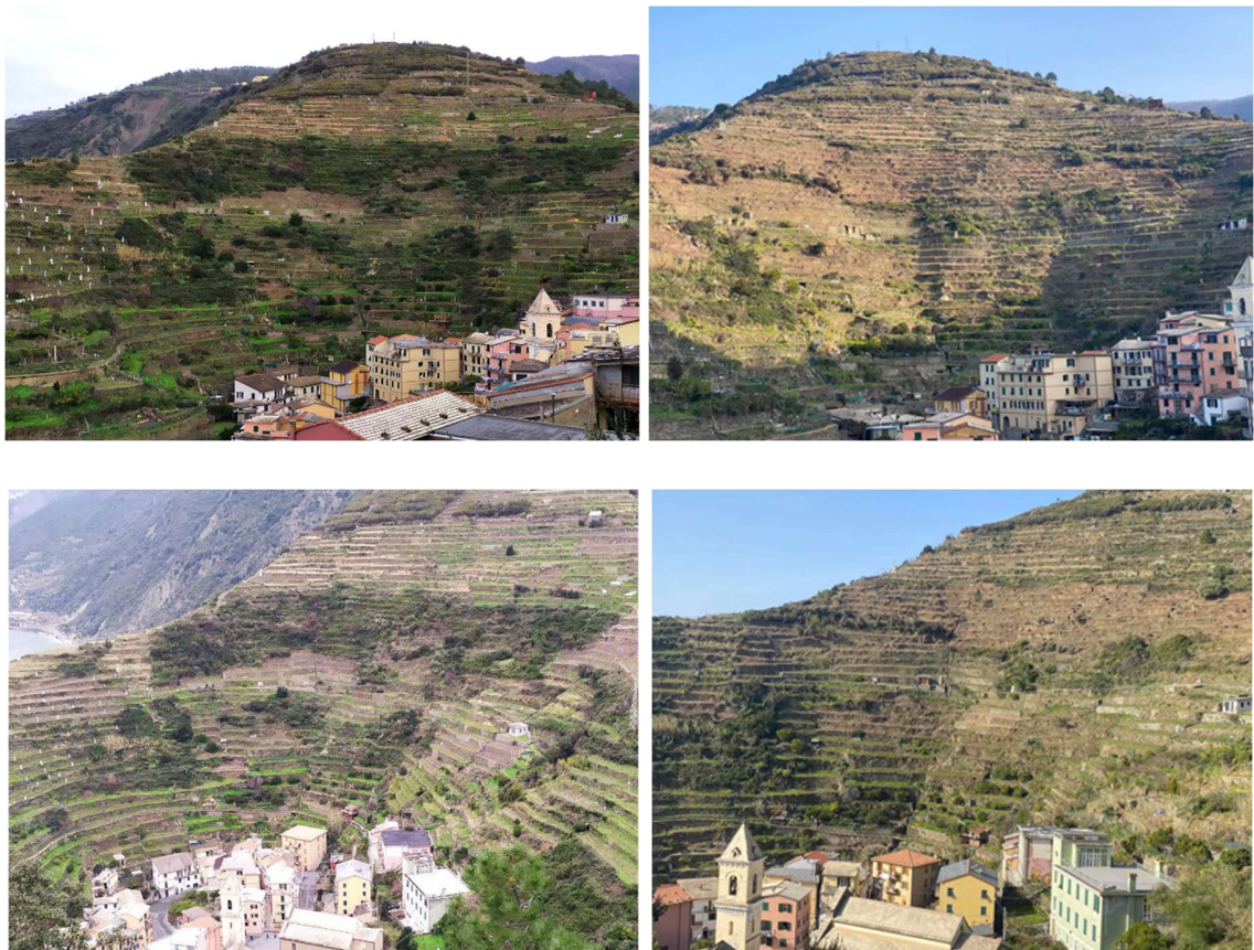
Fig. 16: Le immagini sulla sinistra sono risalenti a gennaio 2020 e raffigurano l'anfiteatro terrazzato di Manarola prima delle azioni di rimozione della vegetazione infestante e dei lavori di ripristino e manutenzione dei muretti a secco. Le immagini poste sulla destra raffigurano invece l'area di intervento a Marzo 2022, dopo l'inizio delle azioni previste dal progetto Stonewallsforlife. Fonte: LIFE Project, STONEWALLSFORLIFE, (2022) Mid-term, Covering the project activities from 01/07/20191 to 31/01/2022 , pg.24.
