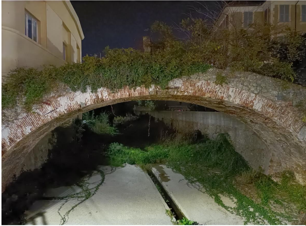
Figura 3 - Ponte di Legino sul Rio Molinero 1
