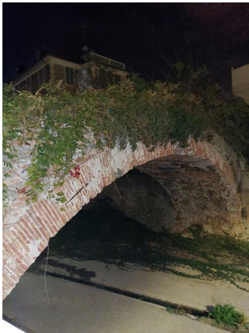
Figura 4 – Ponte di Legino sul Rio Molinero 2
