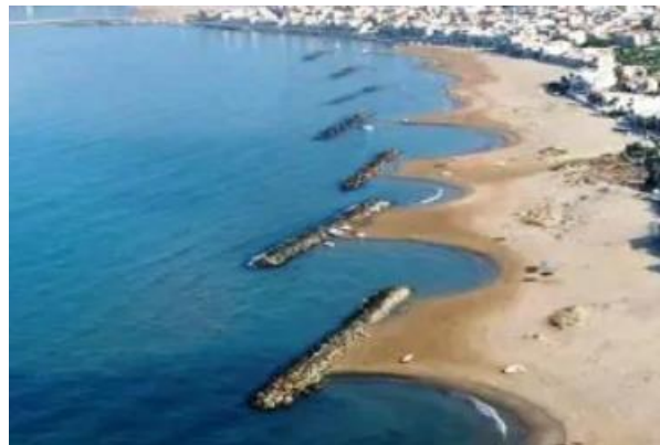
Figura 5 - Pennelli (Tratta da: https://www.meteoerosione-costiera-le-possibili-soluzioni )
