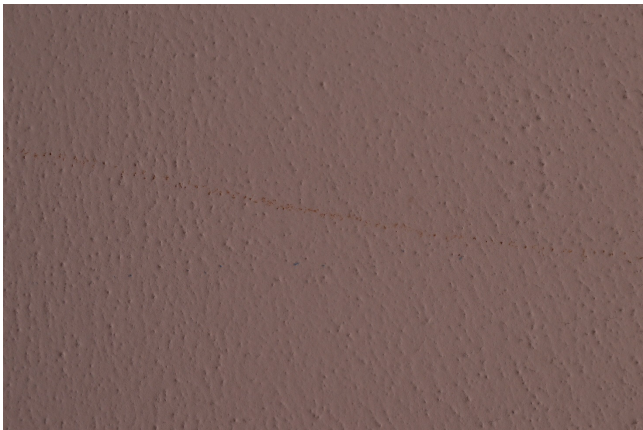
Fig. 46 Sbavatura di colore rossastro.
