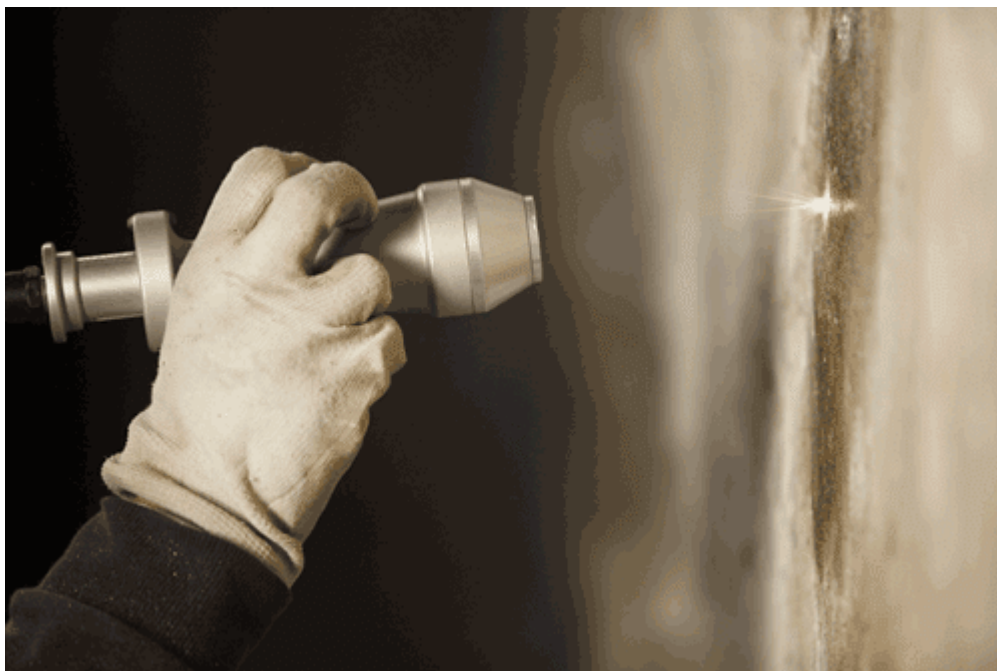
Fig. 28 Procedura di pulitura con laser
