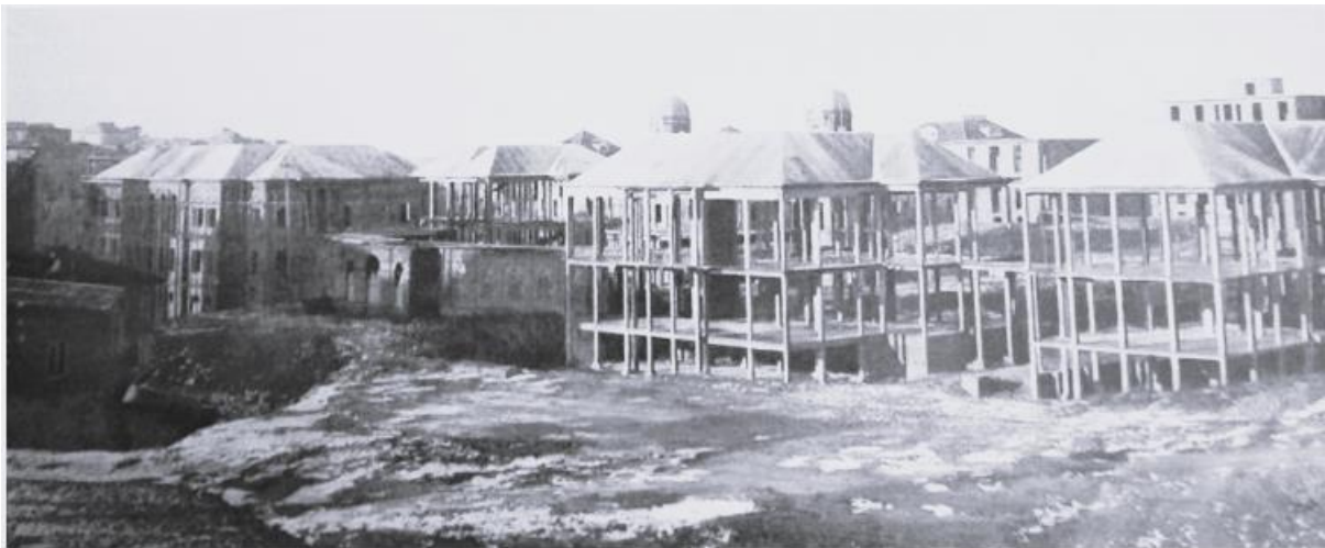
Figura 8: Foto sul cantiere della “cittadella universitaria” (da archivio “area conservazione edilizia”)
