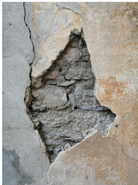
Figura 17: Muratura visibile sul lato sud-ovest – Rilievo 24/01/22
