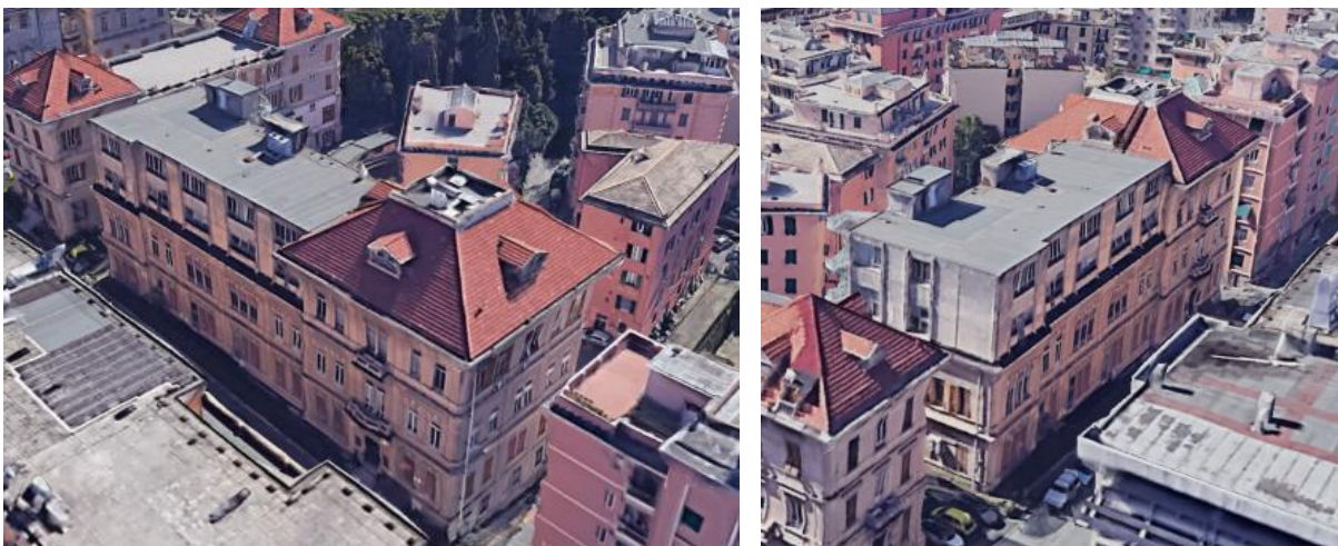
Figura 15: Vista aerea da Nord e da Est dell'edificio (da Google Earth)
