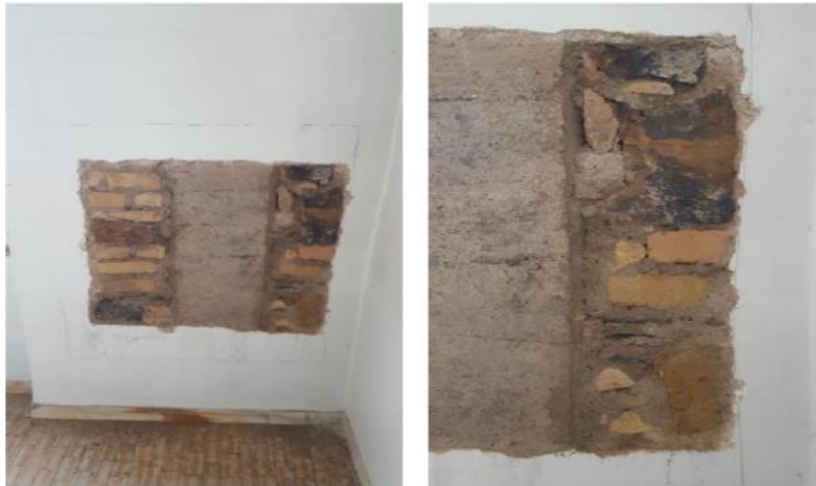
Figura 12: Peeling di un muro interno (da Jamil H.)
