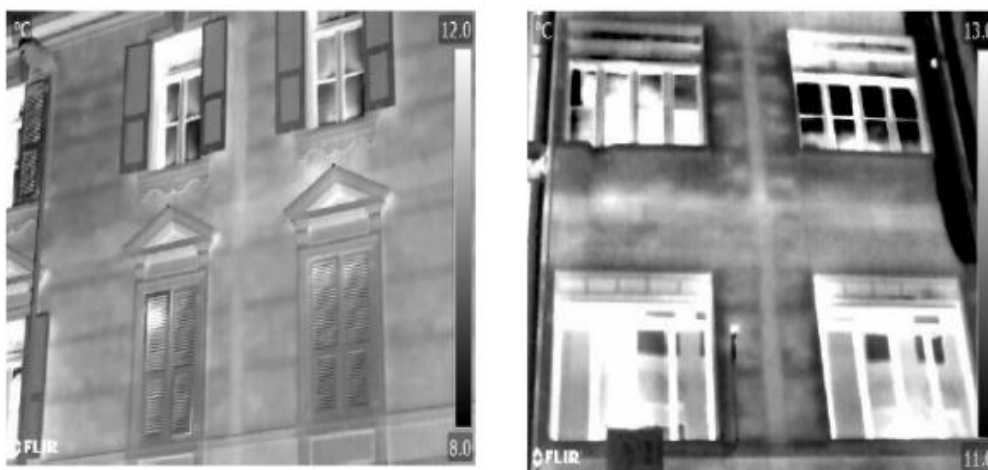
Figura 10: Rilevazione termografica dell'esterno dell'edificio (da Jamil H.)
