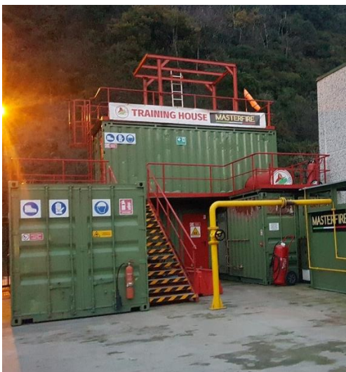
Figura 2.2 – Training House di Masterfire Antincendio . Si tratta di una struttura composta da quattro container collegati tra loro attraverso un articolato percorso interno.
