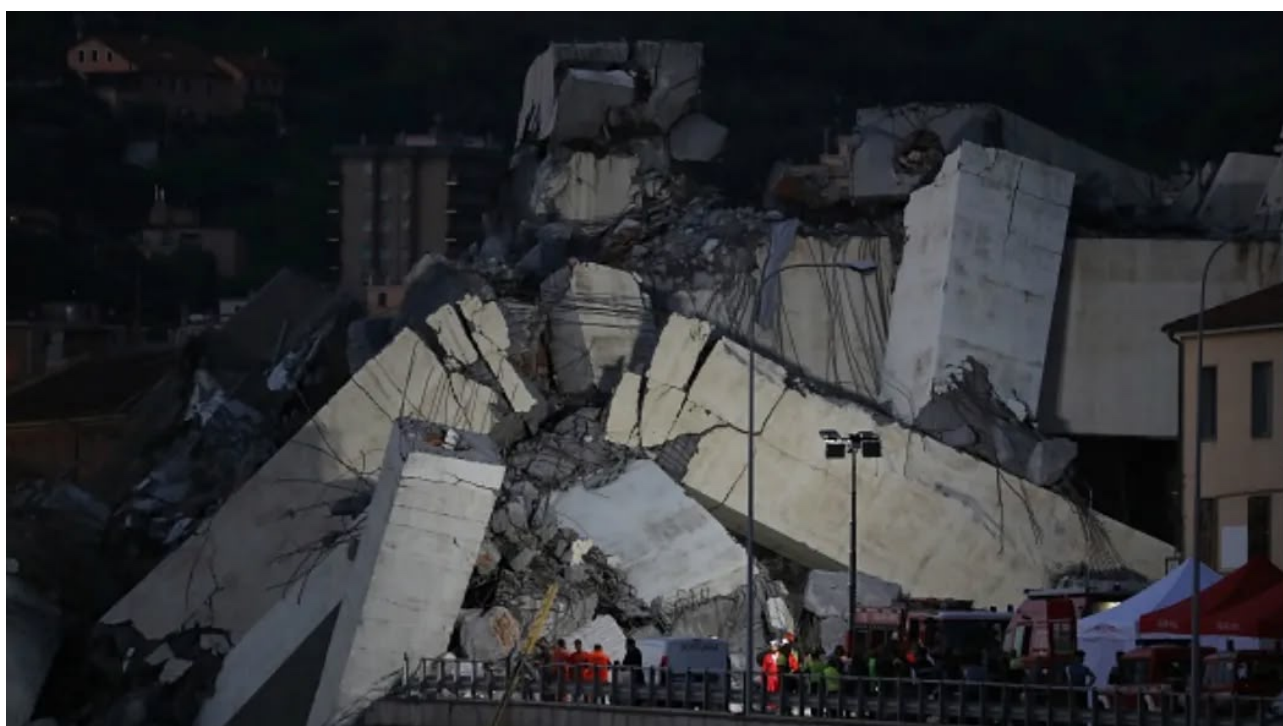
Fig. 5 – Macerie del Ponte Morandi a Genova e presenza dei soccorritori nelle ore successive al crollo del 14 agosto 2018. Fonte: Andrea Leoni / Getty Images, immagine consultata online il 7 settembre 2026
