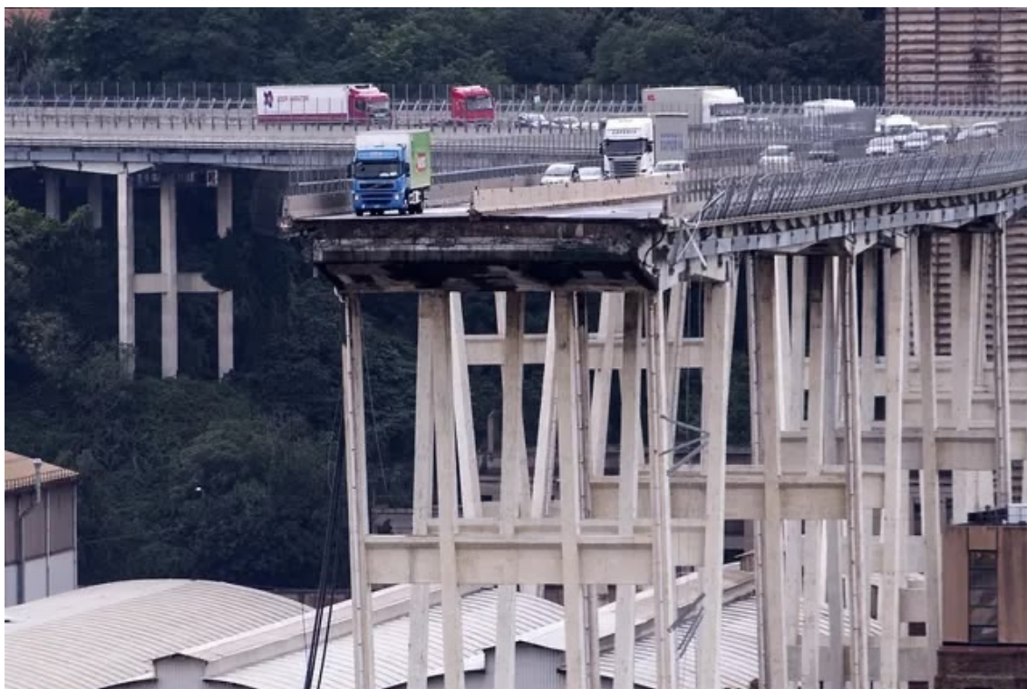
Fig. 4 – Crollo del Ponte Morandi a Genova, veduta generale dell'area colpita e dei tronconi del viadotto dopo il cedimento del 14 agosto 2018. Fonte: Paolo Rattini / Getty Images, immagine consultata online il 7 settembre 2026.
