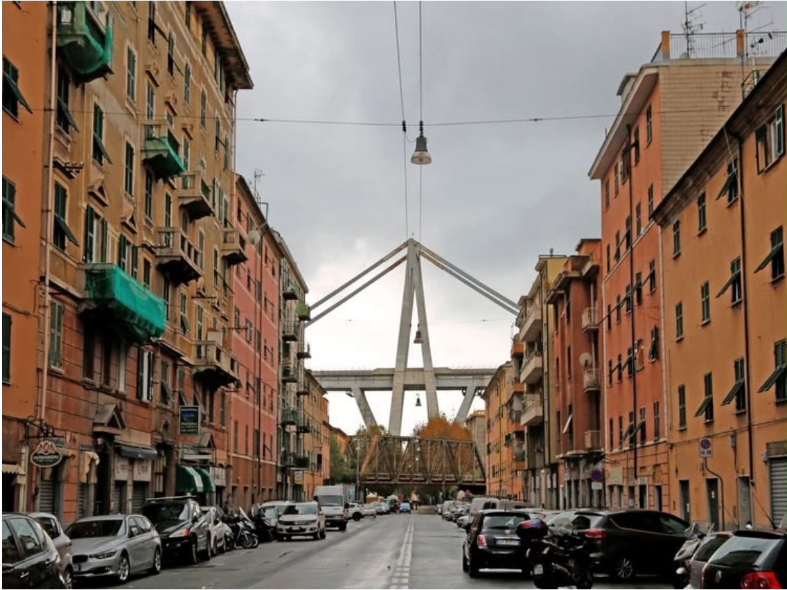
Fig. A6 – Via Fillak a Certosa nei mesi successivi al crollo del Ponte Morandi, con i resti del viadotto sullo sfondo. Foto di Sarah Serafini. Fonte: Watson, Genua steht still, 14 novembre 2018, consultato l'11 settembre 2026.
