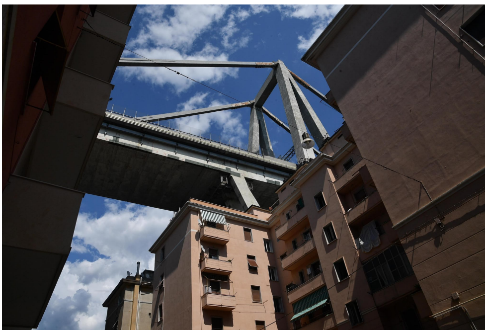
Fig. A11 – Le palazzine di via Porro a ridosso del viadotto Morandi, prima delle demolizioni successive al crollo del 14 agosto 2018. Fonte: Giornale di Sicilia, 2018
