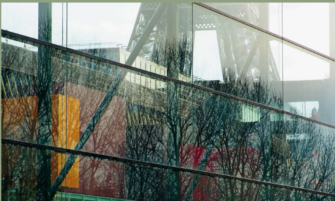
Facciata vetrata continua, Musée du Quai Branly Fonte: Ateliers Jean Nouvel
