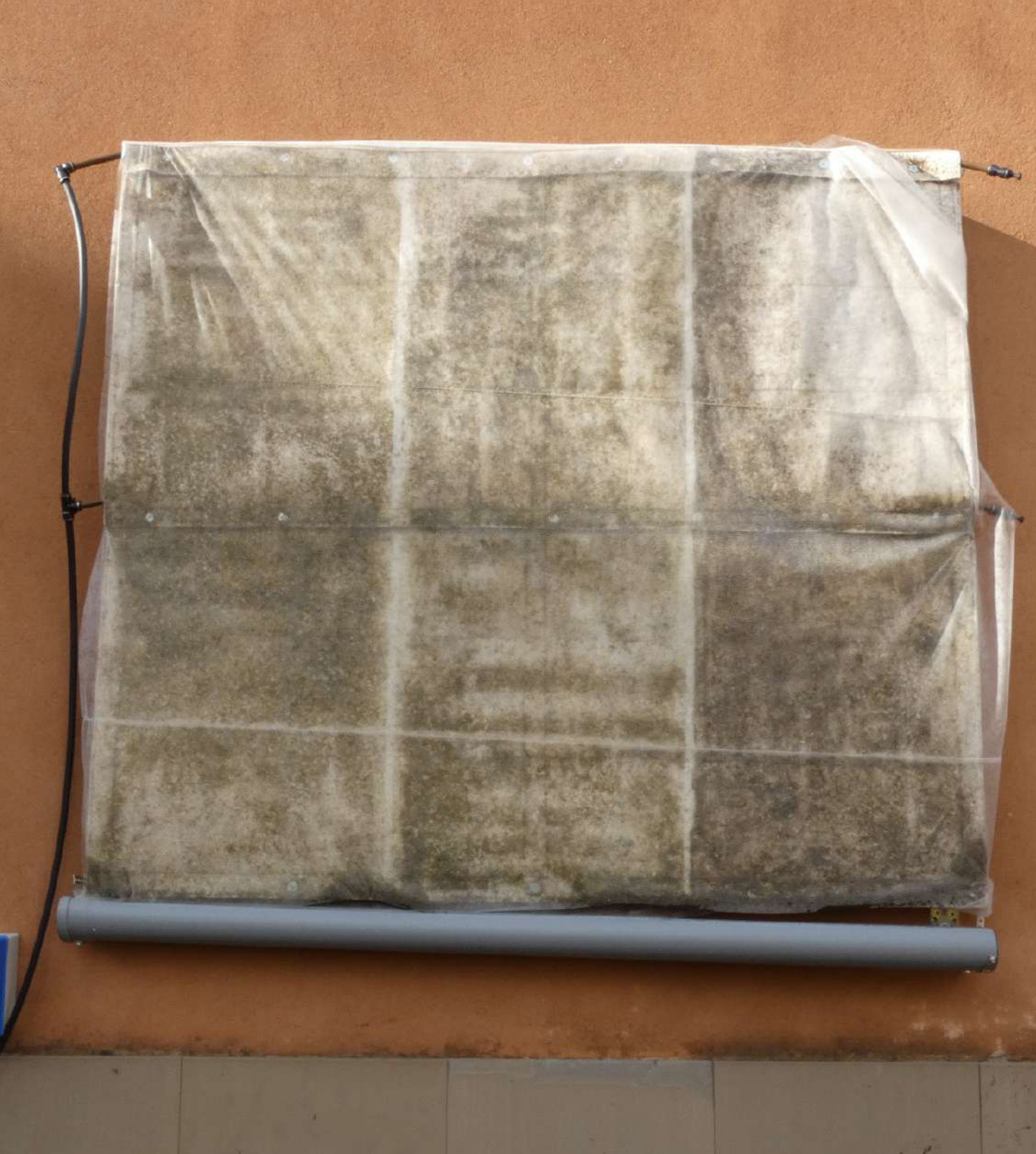
Sopra e a lato: installazione dimostratore sistema MosSkin presso il Dipartimento di Architettura e Design, Università degli Studi di Genova Fotografie originali
