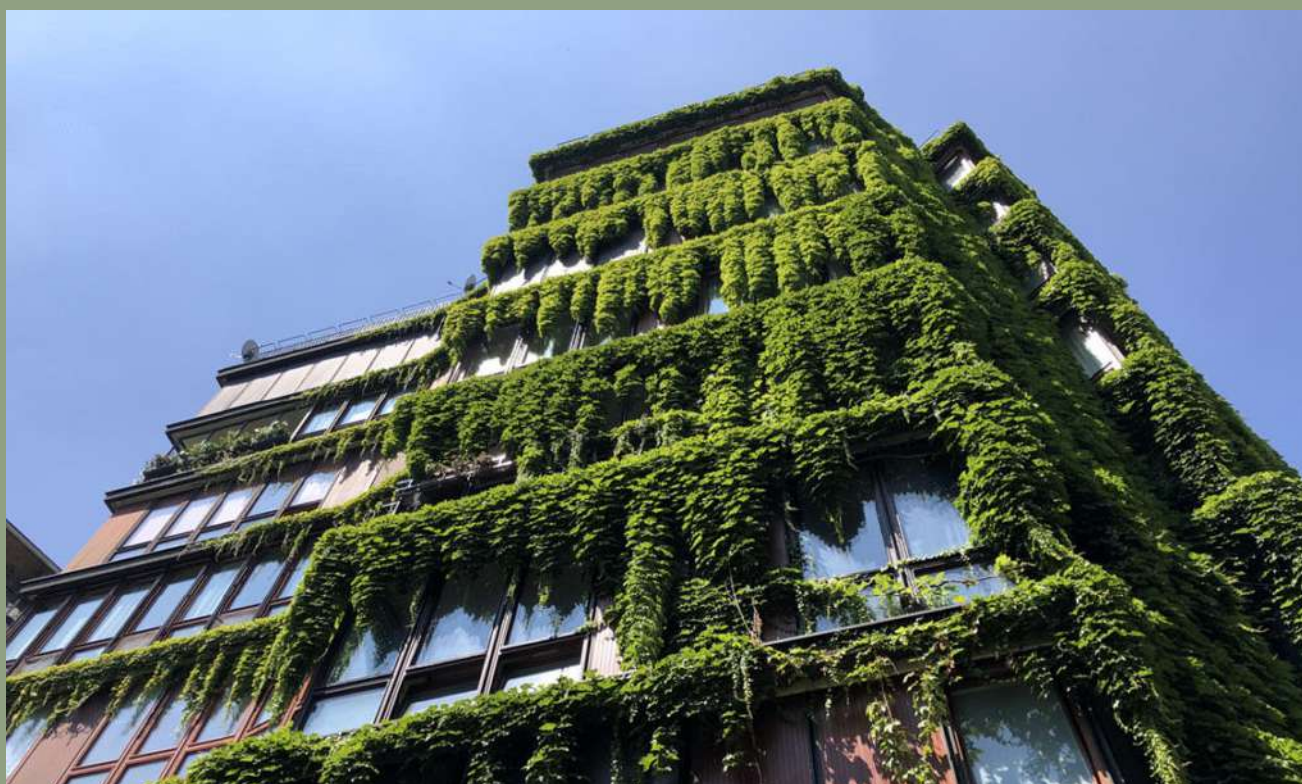
Facciata laterale edificio Via Quadronno 24 Fonte: Urban Life
