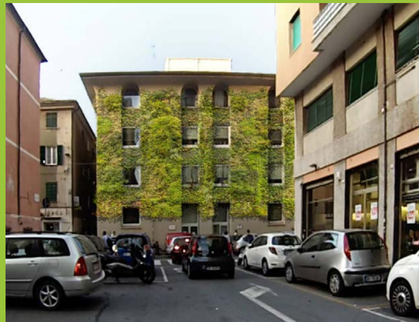
Sopra: Copertura a verde della Cantina Antinori, San Casciano Val di Pesa, Firenze, Archea Associati, 2012. Fonte: Archea Associati. Sotto: Facciata verde verticale dell'edificio INPS di via Ciro Menotti, quartiere di Sestri Ponente (Genova), realizzata dal Dipartimento di Scienze per l'Architettura (DSA) dell'Università di Genova.
