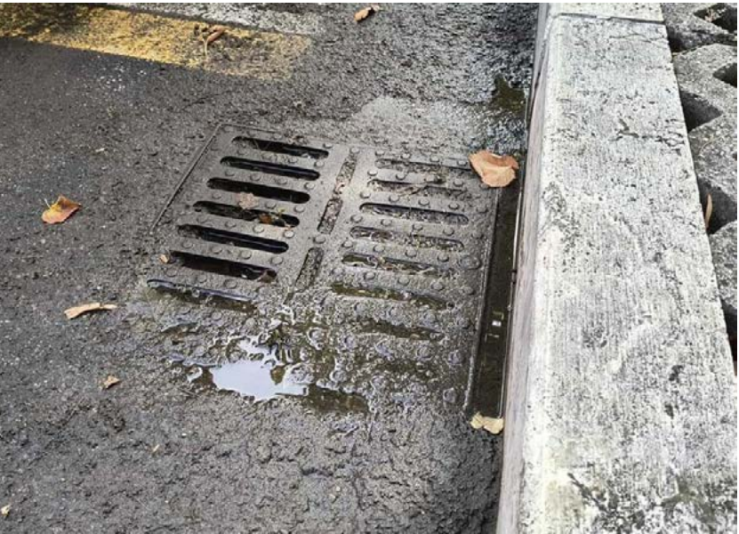
sopra: Inondazione dell'abitato di Solarolo (Ravenna) durante l'alluvione dell'Emilia-Romagna, 17 maggio 2023. Fonte: Carra (2024) sotto: Caditoia stradale parzialmente ostruita da foglie e detriti
