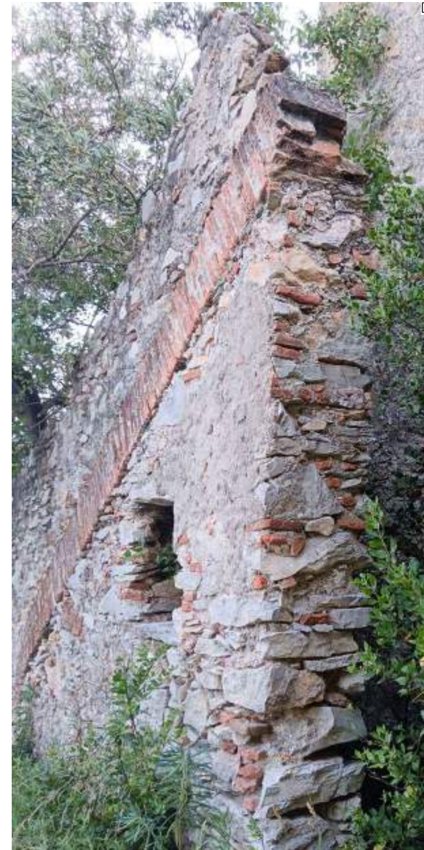
05: Acquisizione fotografica della porzione di parete sottostante la vecchia scala
