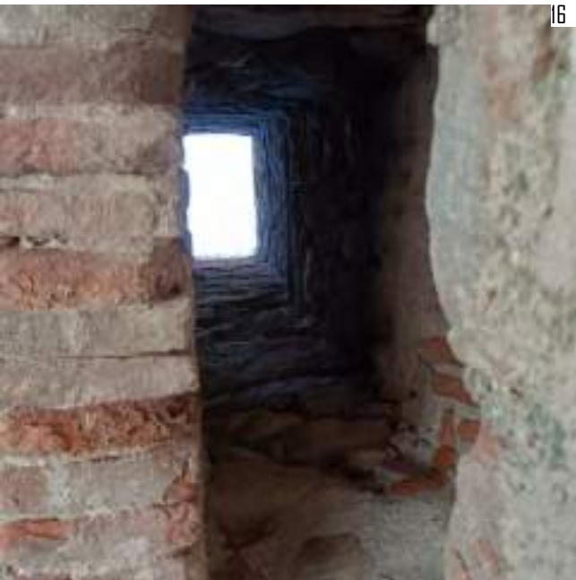
16: Acquisizione fotografica della canna fumaria dall'interno
