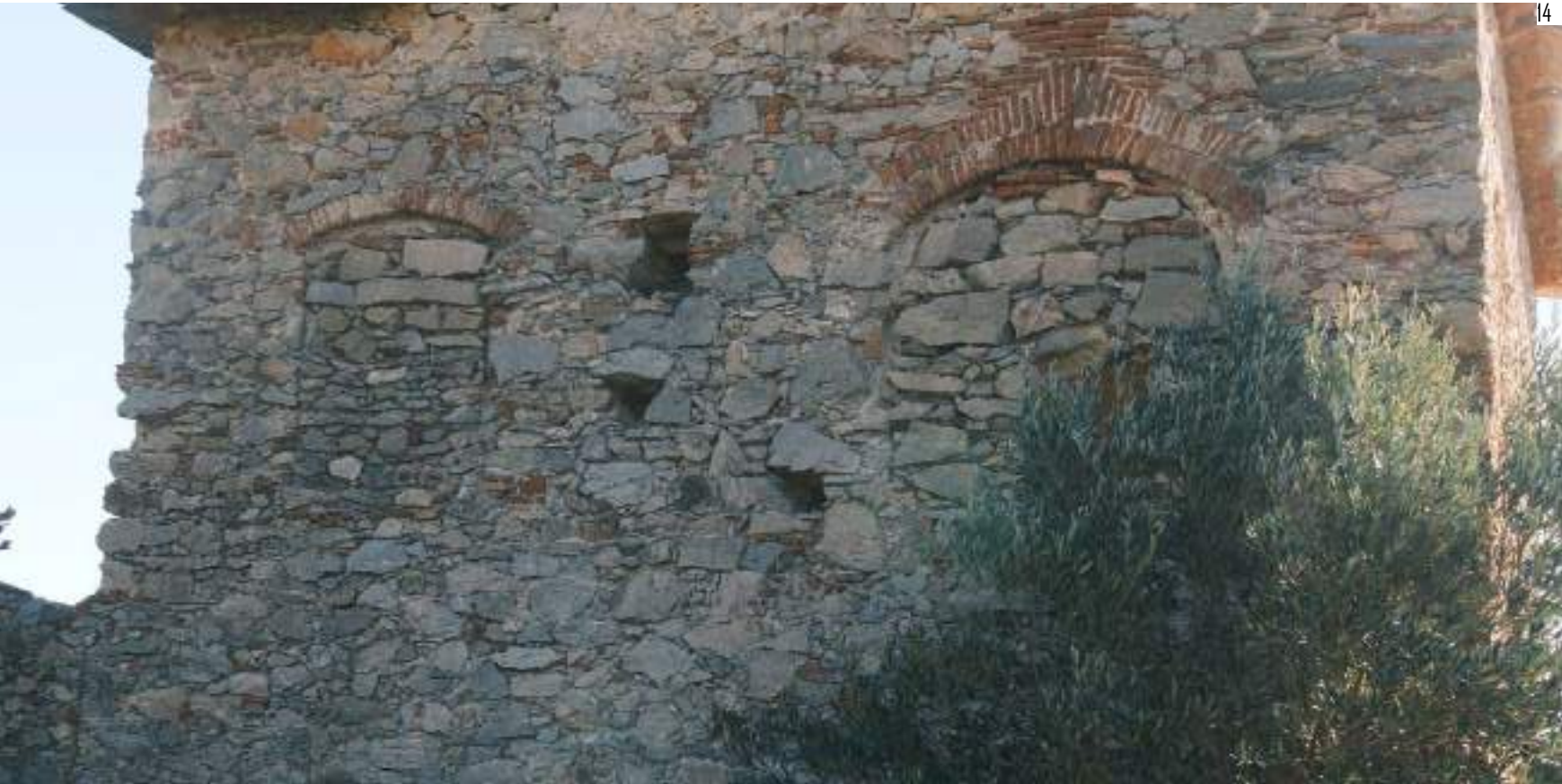
14: Acquisizione fotografica delle tamponature sul lato nord
