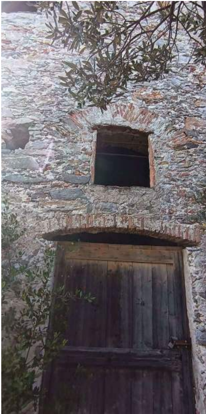
04: Acquisizione fotografica della porta d'accesso al piano terreno
