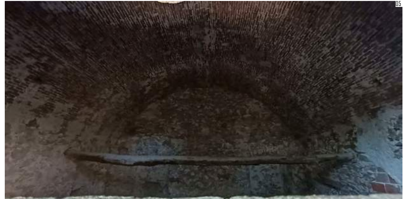
05: Acquisizione fotografica della volta a botte al piano terra
