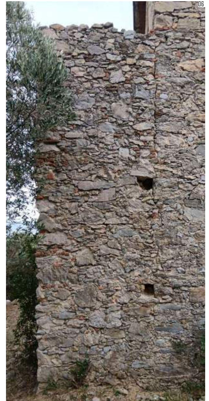
06: Acquisizione fotografica della parete terminale dell'arco rampante crollato
