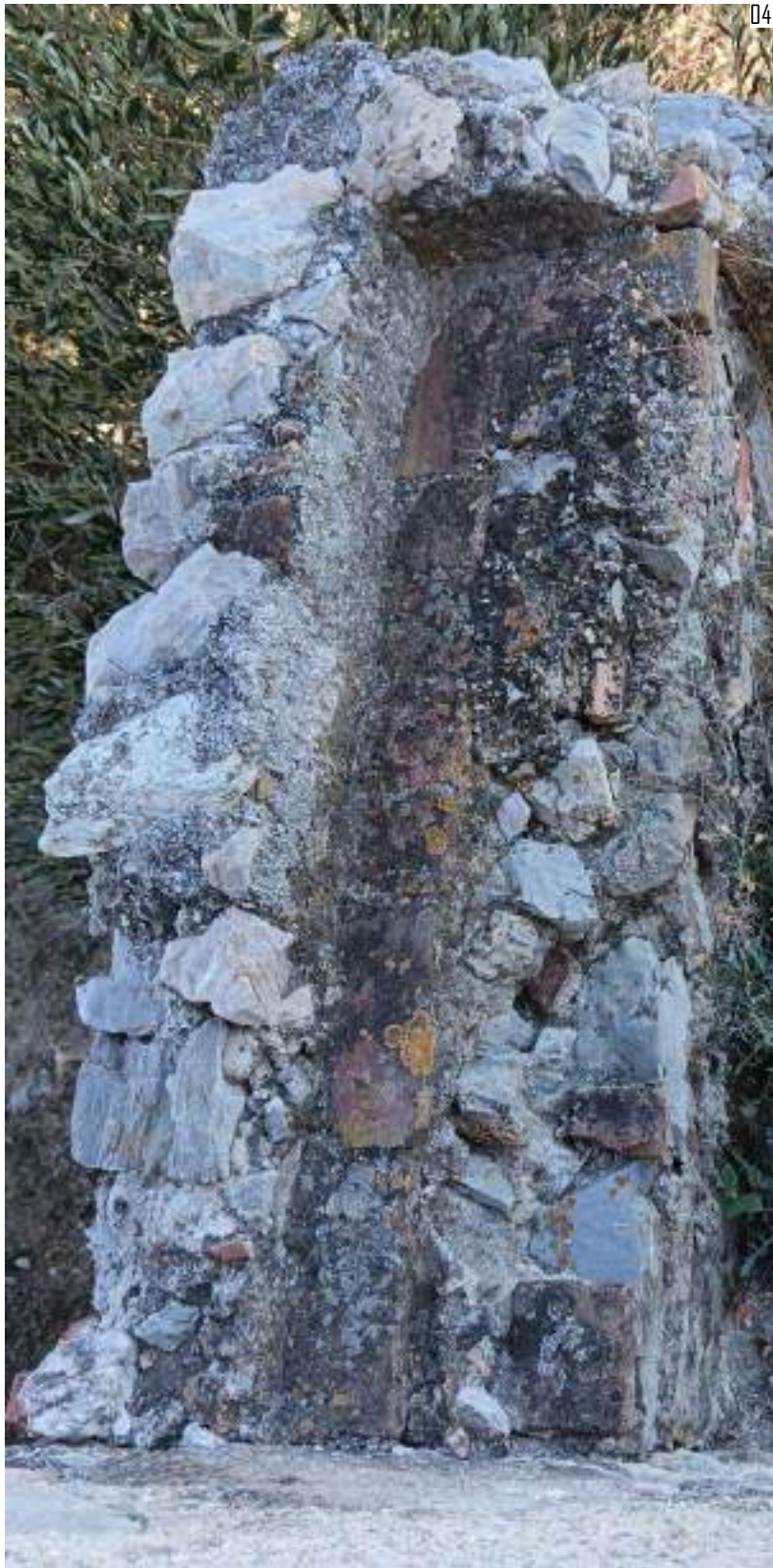
04: Acquisizione fotografica dall'alto della parete di appoggio della vecchia scala
