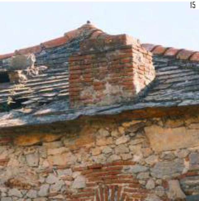
15: Acquisizione fotografica della canna fumaria sul lato nord
