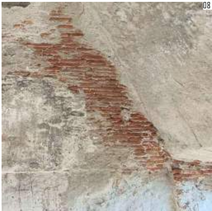
07: Acquisizione fotografica della traccia lasciata dall'arco rampante
