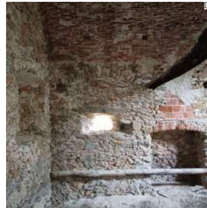
06: Acquisizione fotografica della parete est del piano terra
