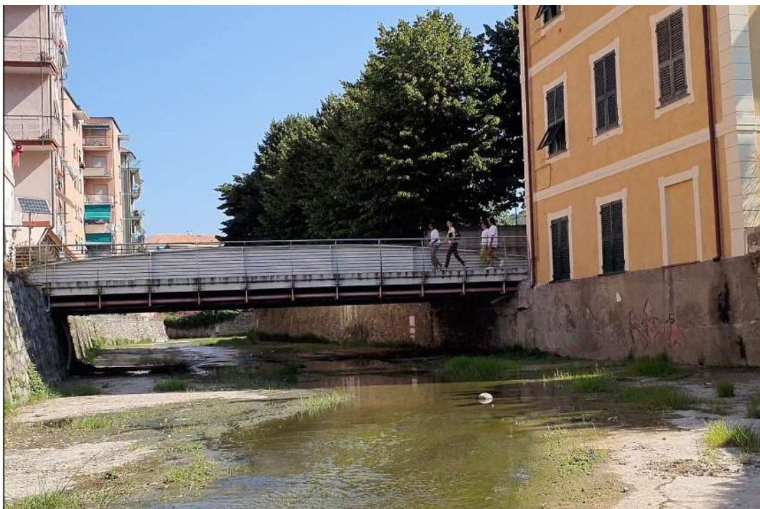
Figure 5.8 - Ponte di Via Castagnola (vista verso monte)
