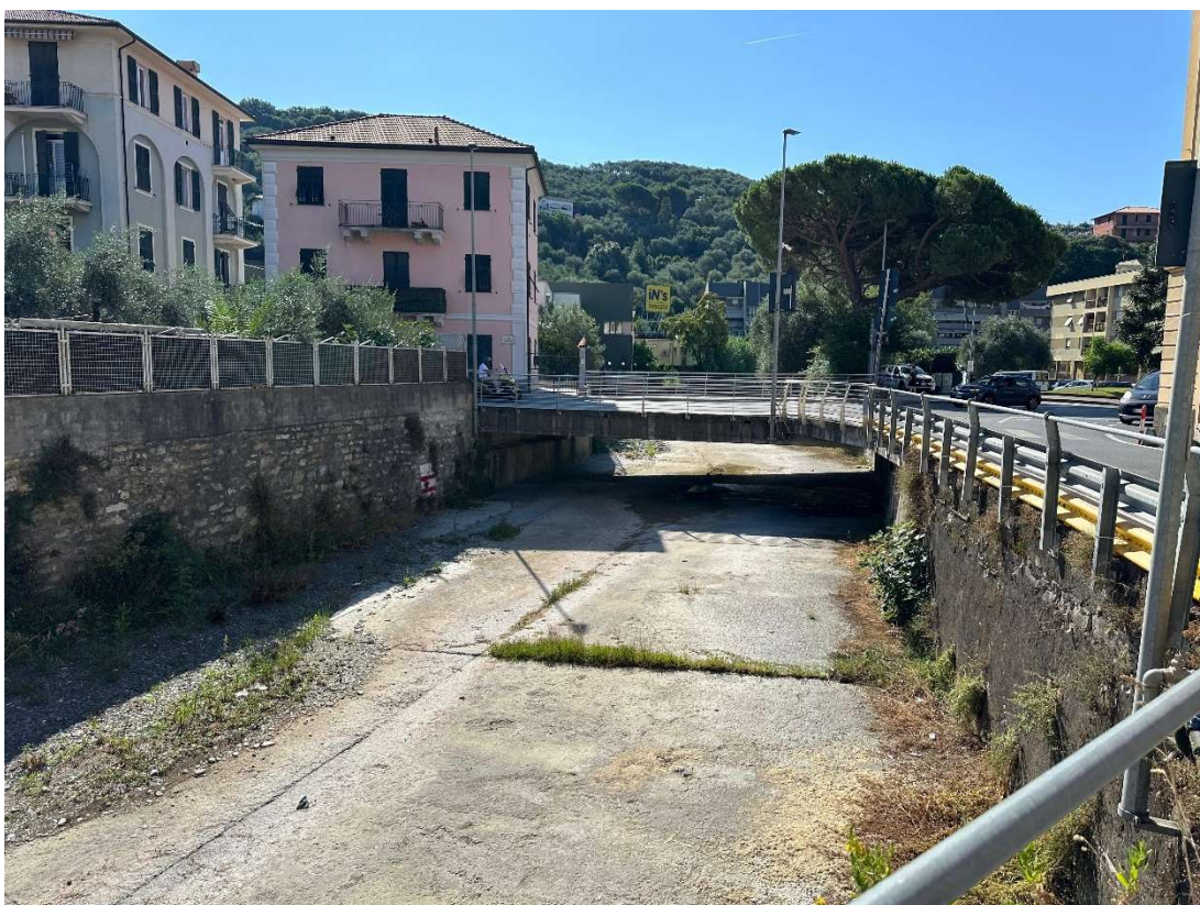
Figure 5.9 - Ponte di Via S. Ruffino (verso valle)
