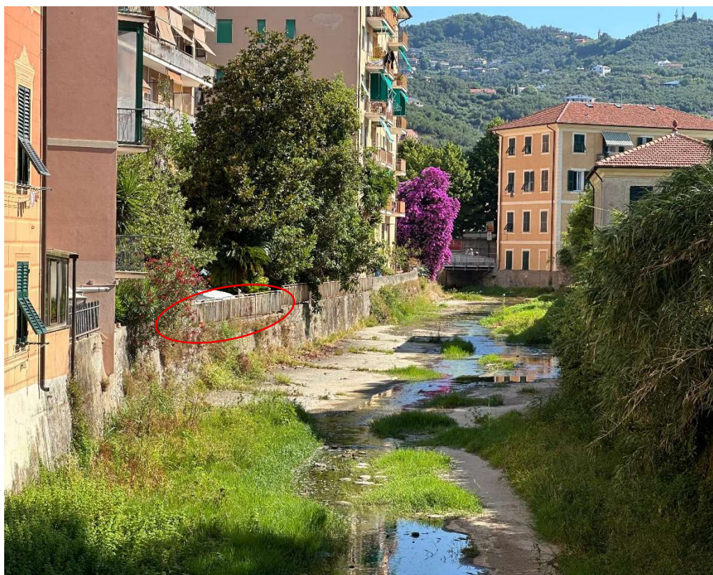
Figure 5.2 - Vista dal ponte di Via Descalzi verso monte (tronco 1)
