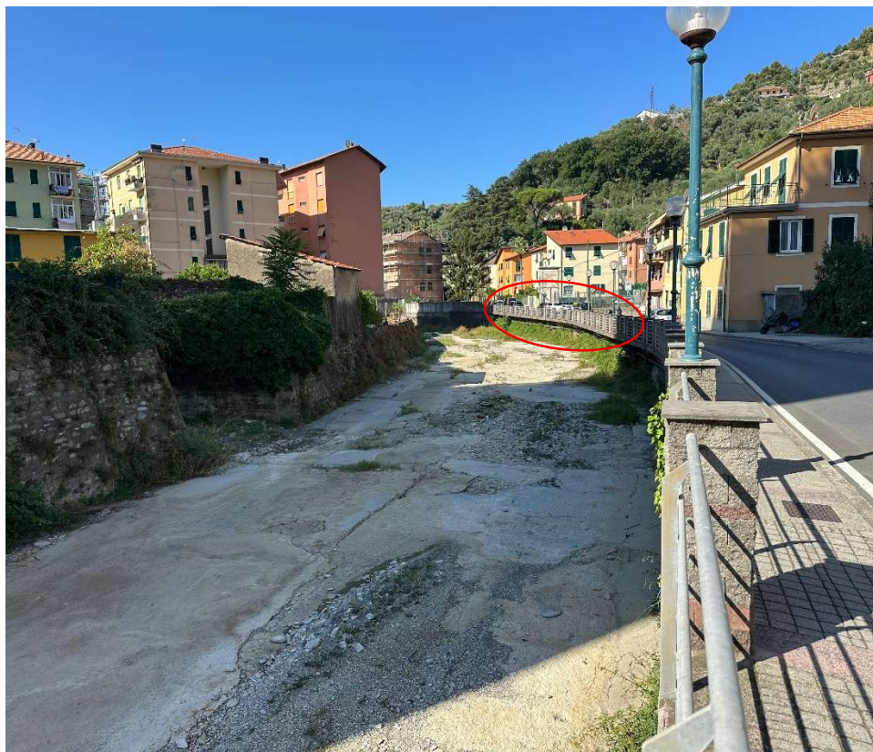
Figure 5.3 - Vista dal ponte di Via S.Pier di Canne verso valle (tronco 2)
