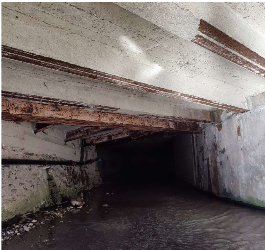
Figure 5.14 - Vista verso monte del sistema di travi nel tratto terminale della copertura
