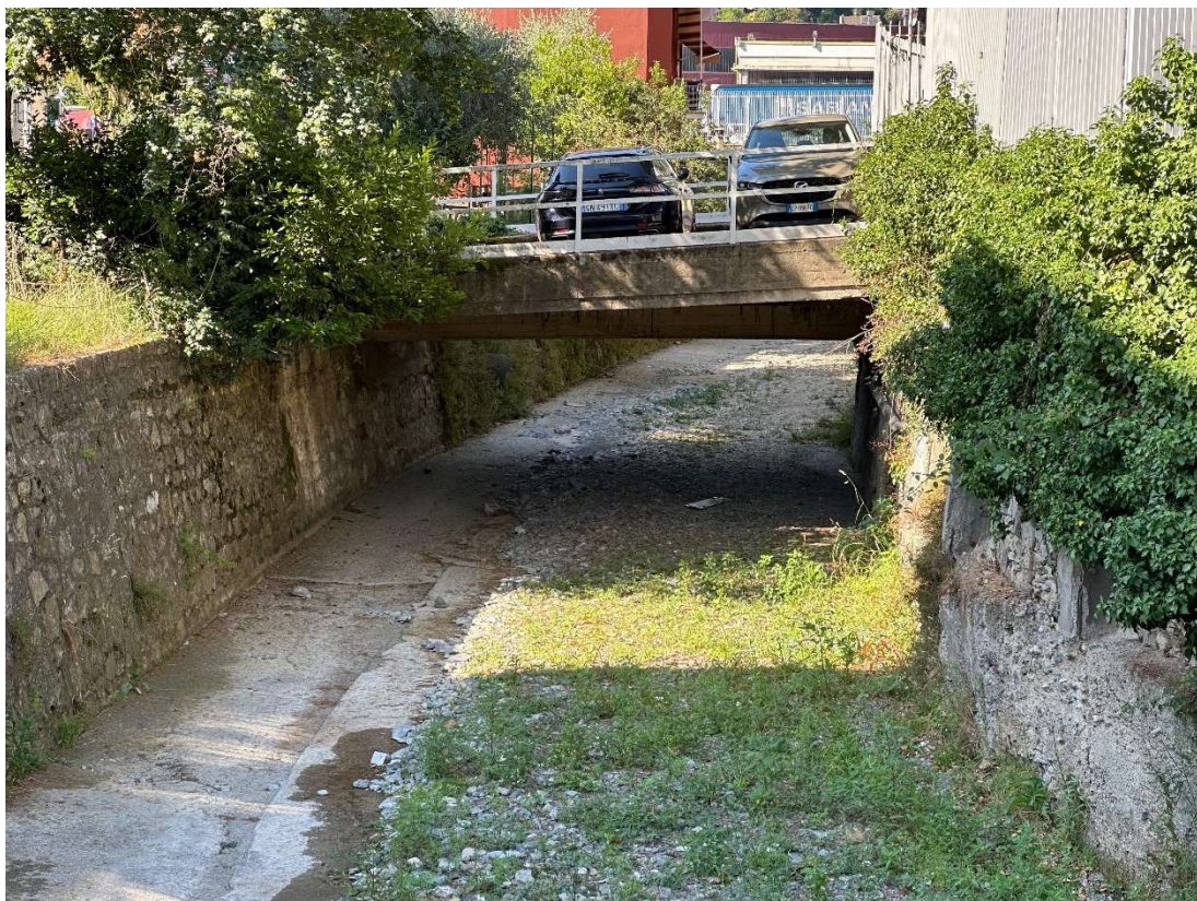
Figure 5.10 - Ponte Hi-Lex (verso valle)
