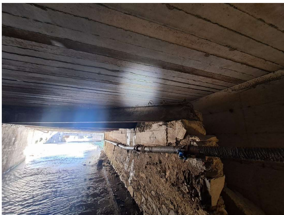
Figure 5.13 - Vista verso valle del resto della spalla del vecchio ponte e relative travi
