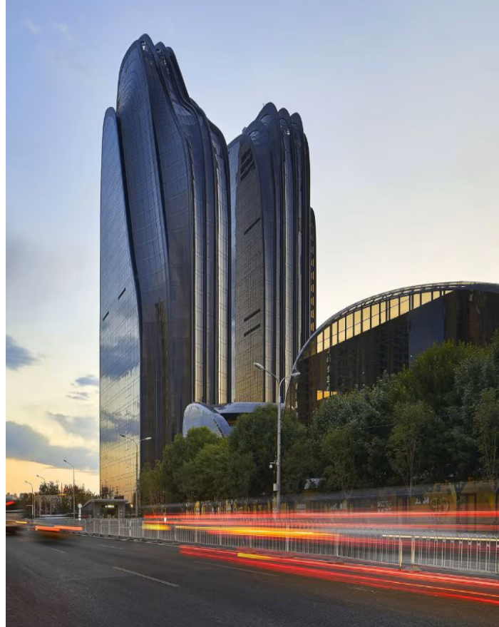
Immagine n.22 | Chaoyang Park Plaza di MAD Architects a Pechino https://www.domusweb.it
