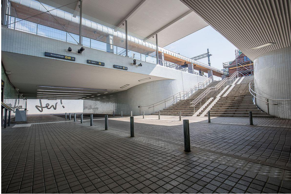
Figura 18. Il tunnel di Haga ad Umea- fonte: https://commons.wikimedia.org/wiki/File:GC-tunneln_vid_Ume%C3%A5_centralstation_01.jpg ;
