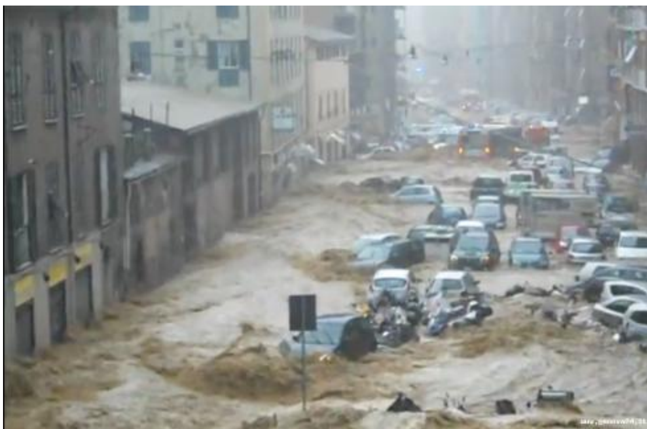
Figura 41: L'esondazione del torrente Fereggiano il 4 novembre 2011.
