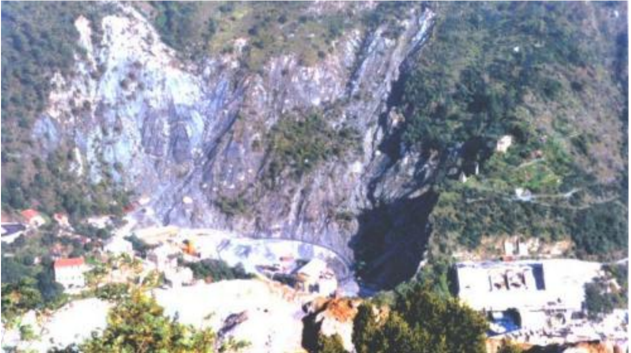
Figura 36: Smottamento di natura complessa presso il bacino del torrente Chiaravagna (Piano di bacino, stralcio per l'assetto idrogeologico del torrente Chiaravagna).
