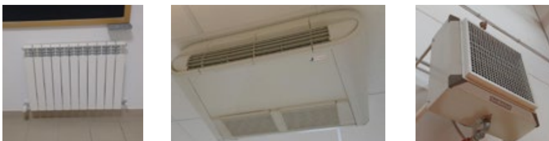
Fig. 6.26 Terminali di riscaldamento: radiatore, vetilconvettore, aerotermo.
