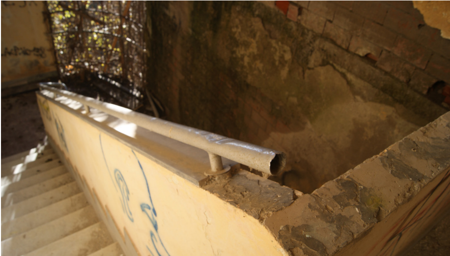
◀ Foto di dettaglio del corrimano e dei gradini in marmo.
