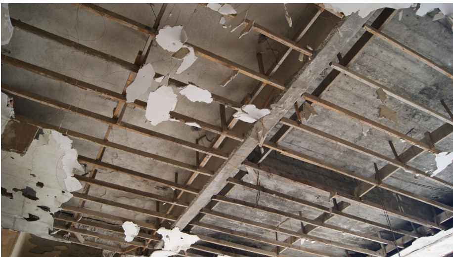
◀ Foto di dettaglio del controsoffitto posto all'ingresso dell'edificio, composto da struttura lignea e metallica.
