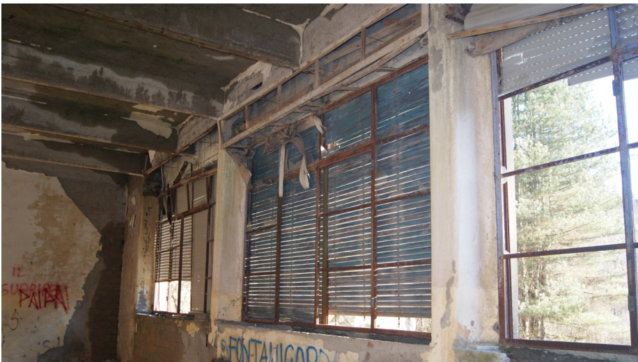
◀ Foto di dettaglio delle finestra con tapparella abbassata da cui si nota il colore originale.
