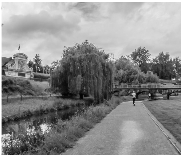
In alto: Pont Napoléon, l'unico ponte pedonale coperto di Francia. Costruito nel 1809, fu poi distrutto due volte dai tedeschi nel 1918 e nel 1940, prima di essere ricostruito praticamente identico nel 2014. Foto di: parcdelacitadelle.lille.fr
