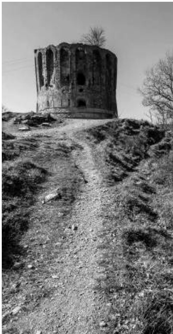
Torre Quezzi. Foto di: foglieviaggi.cloud
