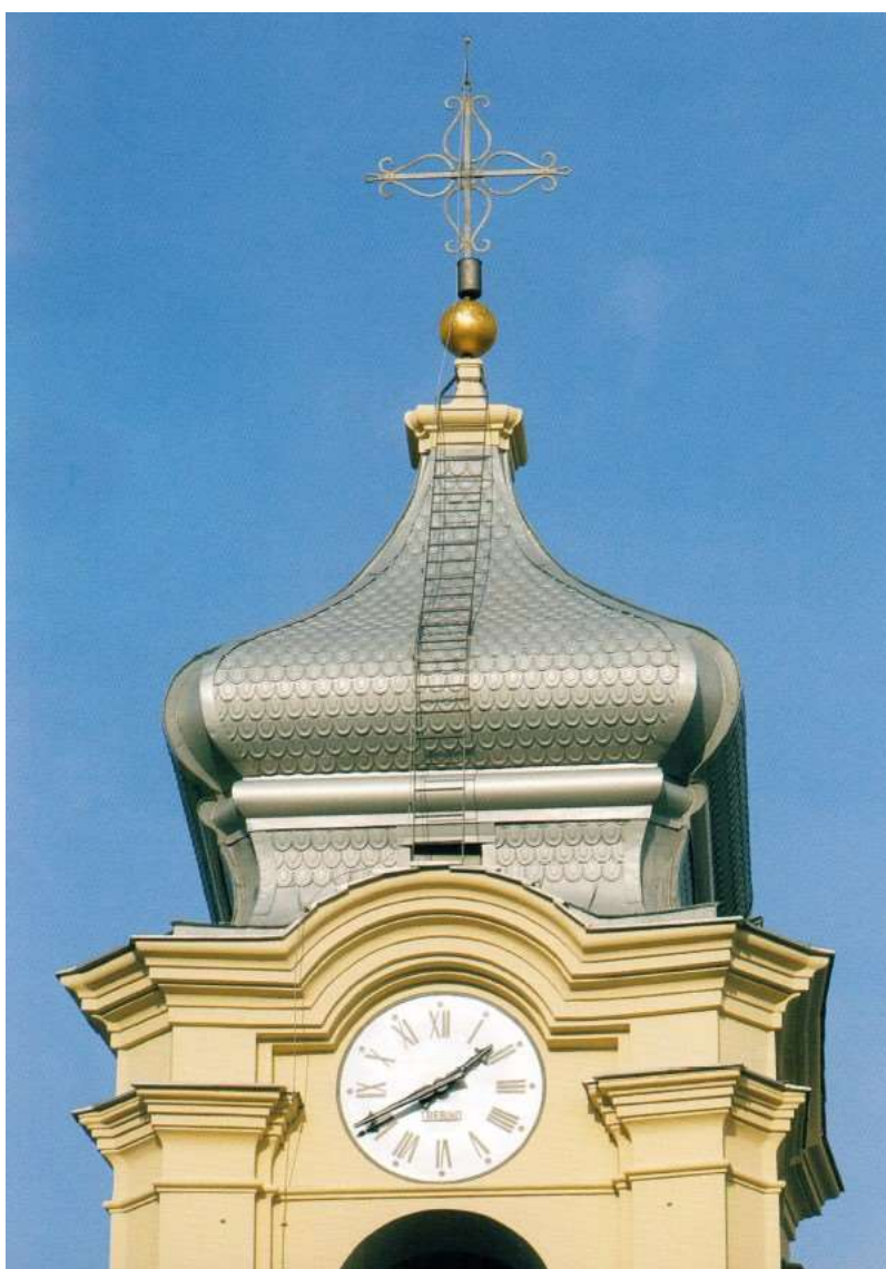
Fig.2.2.1. Torre campanaria dopo il restauro effettuato dalla Società Borini Costruzioni e dallo Studio Tecnico Stella-Franzese e Associati. Si evidenzia la copertura in Rheinzink. (BORINI, 2002).
