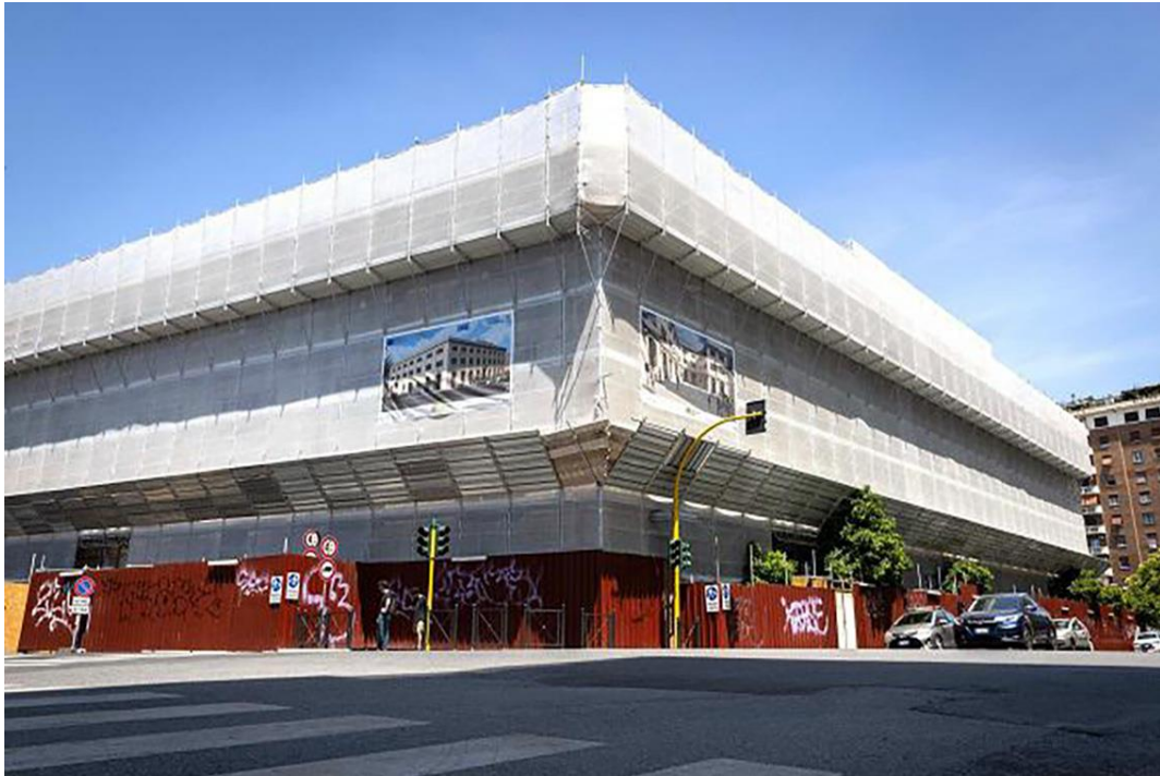
Figura 34. Lo stabile di Porto Fluviale durante i lavori di ristrutturazione dello stabile, 2024.
