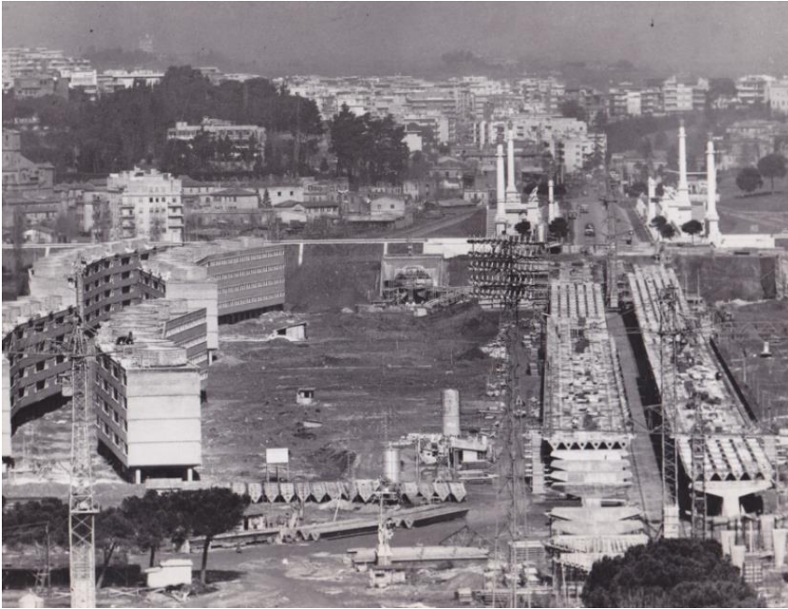
Figura 3. Il cantiere del Villaggio Olimpico, Roma 1958-1960.
