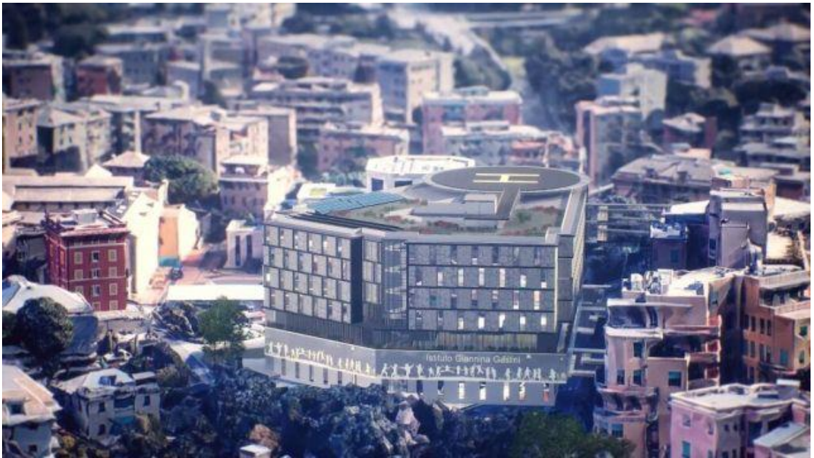
Figura 11 Nuovo Gaslini vista aerea
