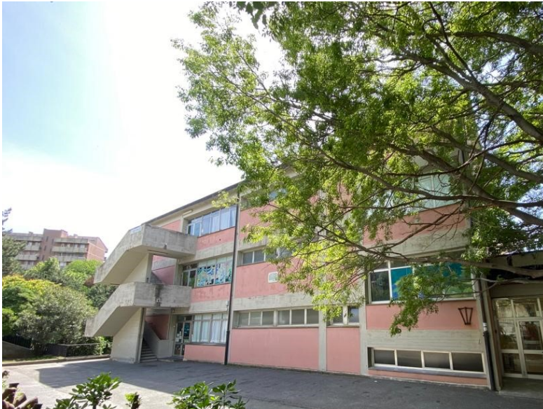
Fig. 4: la scuola vista dall'esterno, entrata principale
