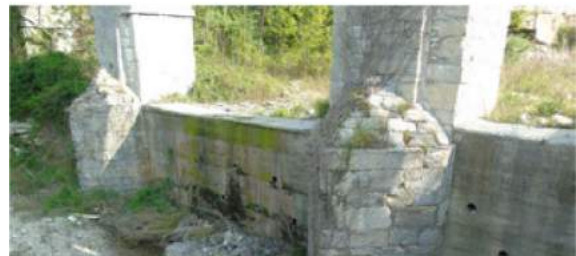
c. Briglia in calcestruzzo armato sotto al Ponte Ronco del 1600
