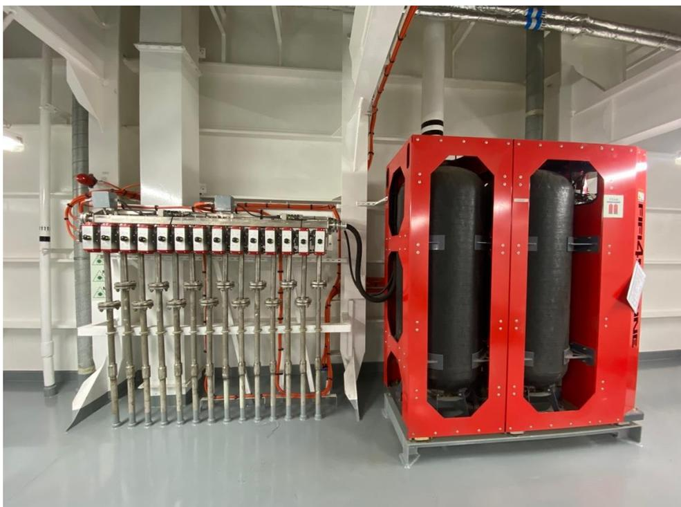
**Figura 13: sistema antincendio batterie<sup>138</sup>**
