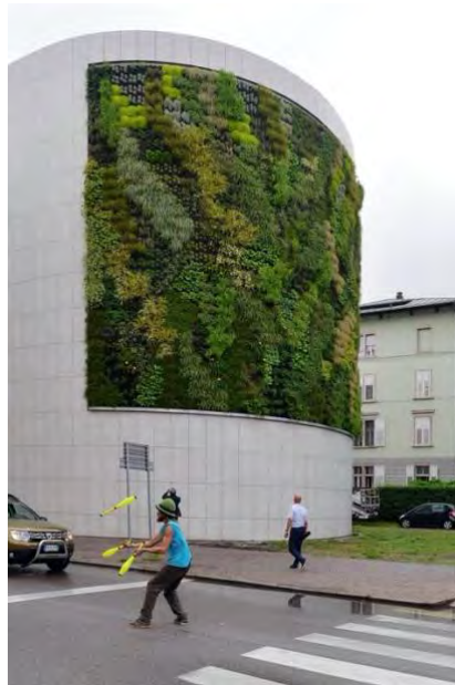
Foto di un riferimento di parcheggio con rivestimento a parete verde verticale: Autosilos Buonconsiglio di Trento (fonte: Google immagini)
