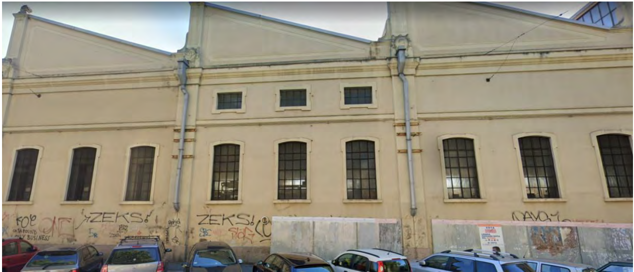
Foto del fabbricato ovest delle Officine da Corso Sardegna (fonte: Google Earth)
