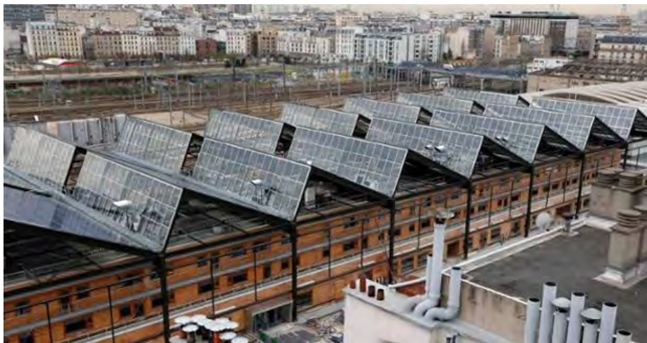
Foto dell'intervento realizzato sul deposito Halle Pajol a Parigi (fonte: Google immagini)
