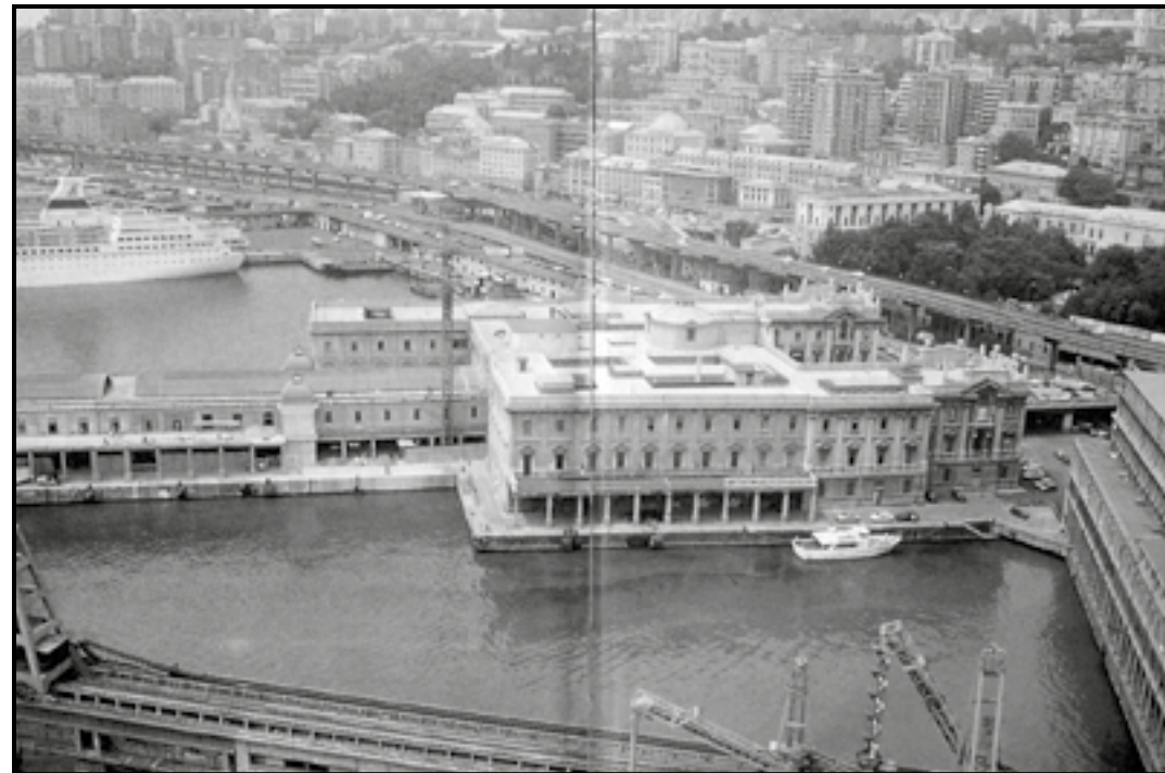
(fig. 13) La Stazione Marittima, nuovo Terminal Crocere - 1991
