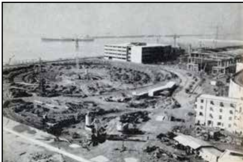
(fig. 36) I lavori per la costruzione dei padiglioni.
