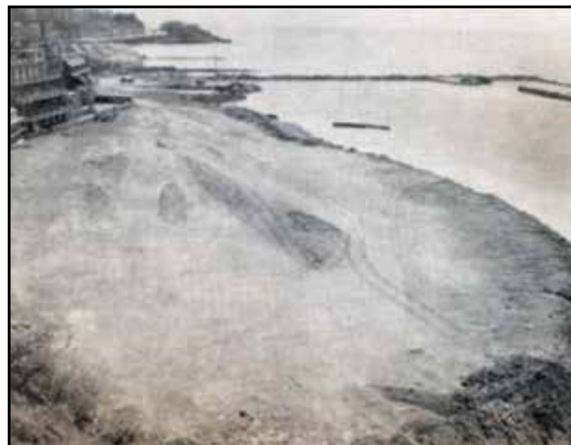
(fig. 35) I primi interramenti per il quartiere fieristico.
