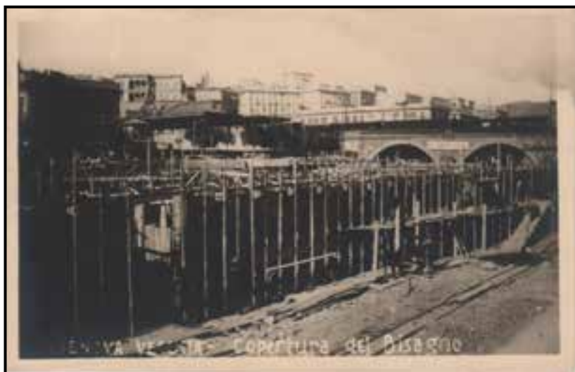
(fig. 33) I lavori per la copertura del Bisagno.
