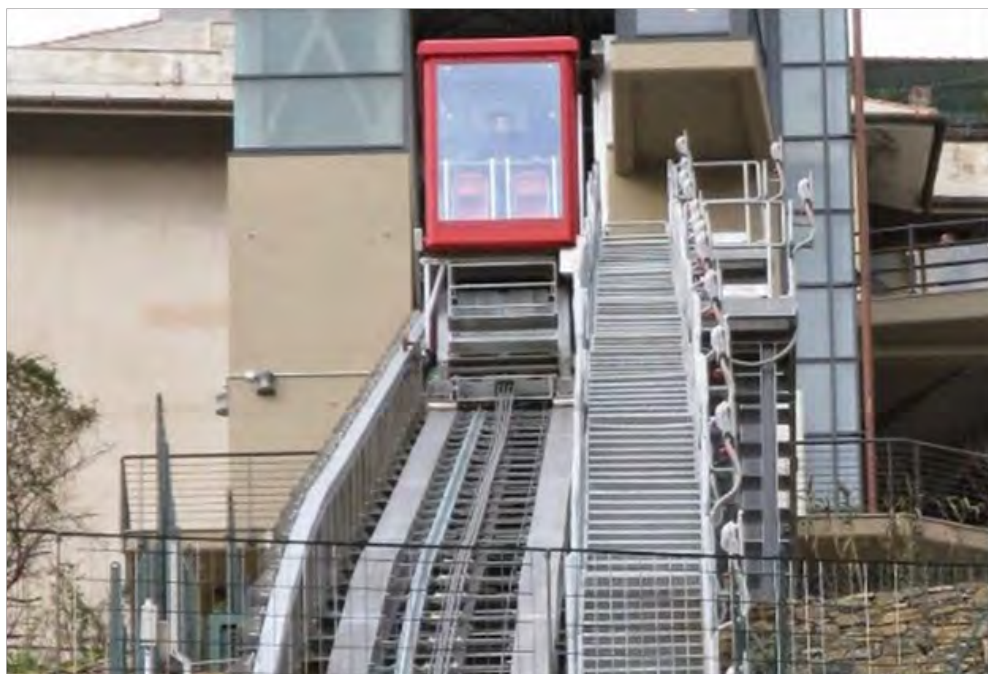
FIG. 3 : Ascensore Quezzi, Genova, 2015.
