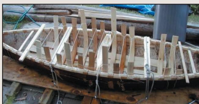
una canoa in fase di costruzione: posizionamento dell'ossatura di rinforzo
